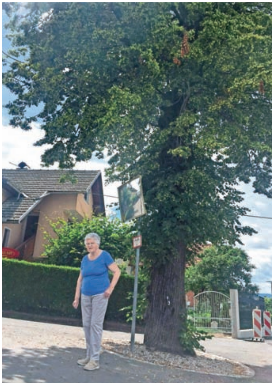
Po zaključku del na javnem kanalizacijskem omrežju so izvajalci gradbenih del simbolično naredili še »ogrlico« krog stare vaške lipa v Britofu. Na sliki je domačinka Ivana Prusnik. / Foto: M. Prusnik
